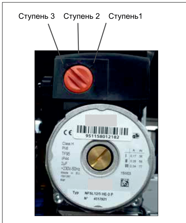
Рис. Ступени переключения насоса
