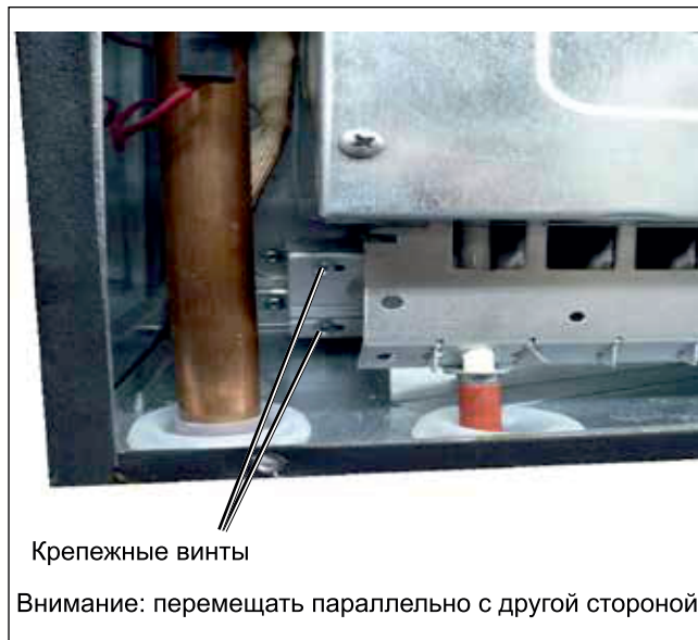
Рис. Корпус камеры сгорания
