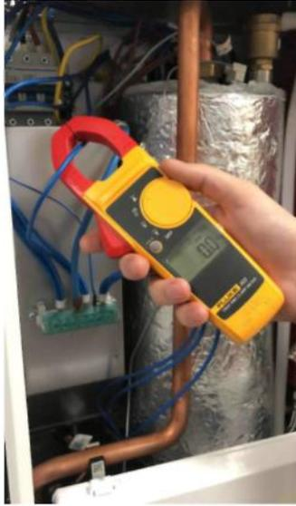
а- Откройте защитную крышку солевой группы и проверьте наличие напряжения на выходных контактах 2,4 и 6 контактора с помощью контрольной ручки. Если между клеммами А1-А2 контактора измерена разница напряжений между 180-240 В переменного тока, замените контактор, если на любом из трех контактов нет напряжения, хотя на входных полюсах контактора есть энергия.
